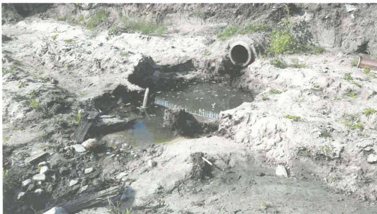
Ryc. 8. Pale drewniane odsłonięte w czasie prac budowlanych
