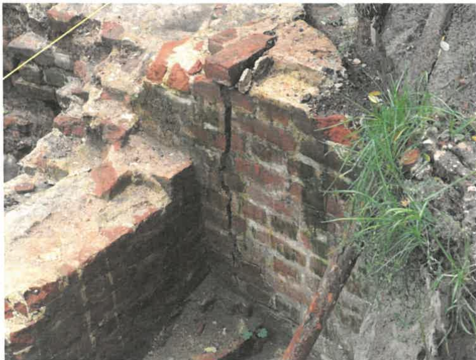
Fot. 9. Zbliżenie fot. 8. Widoczne rozwarście pęknięcia oraz wzrost glonów na powierzchni muru.
