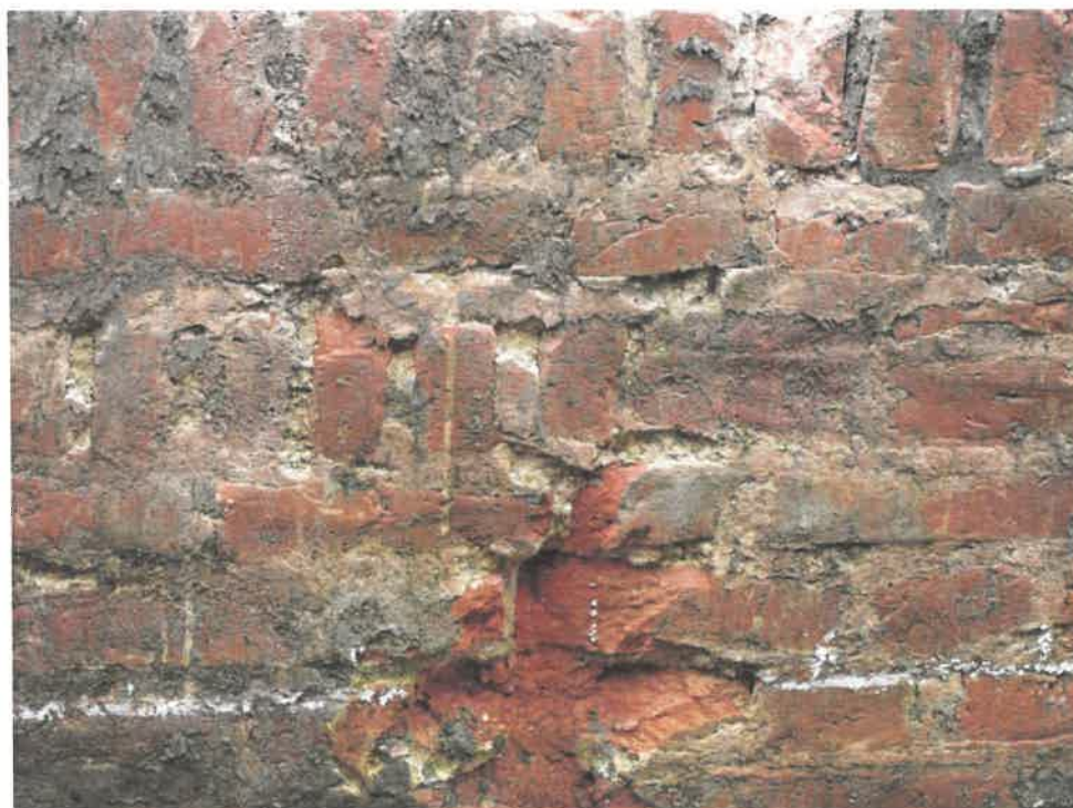
Fot. 7. Zbliżenie z fot. 6. Widoczne powierzchniowe zniszczenia zaprawy w spoinach: spękania, odwarstwienia i ubytki wymagające stabilizacji i uzupełnienia.
