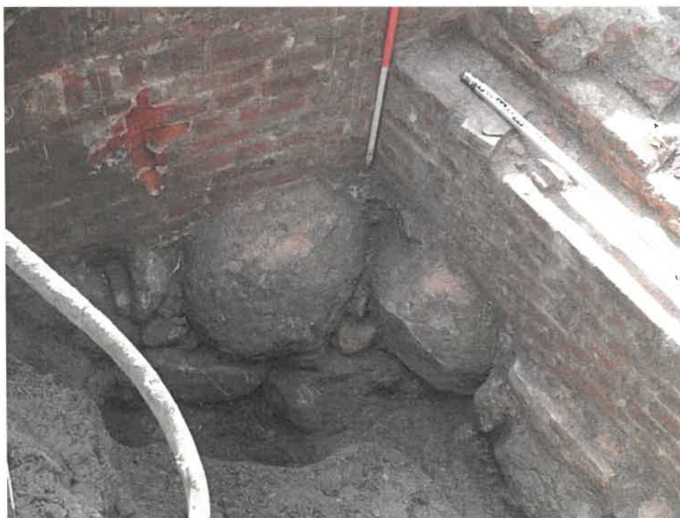
Fot. 3. Fragment murów z widocznymi fundamentami z głazów narzutowych. baszty. (autor fotografii Izabela Mellin-Wyczółkowska)
