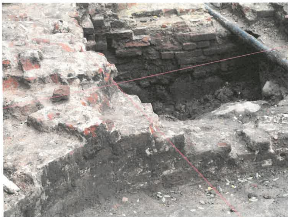
Fot. 2. Fragment murów. Stan zachowania. Widoczne powierzchniowe nawarstwienia gleby , które należy usunąć, oraz zdekompletowane cegły w obrębie poszczególnych warstw.
