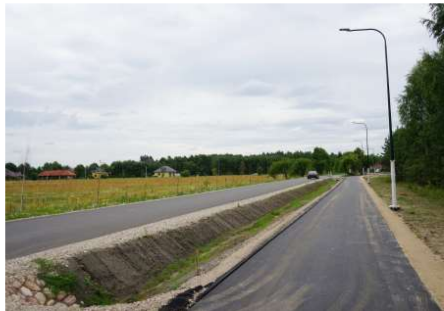
Zdjęcie wykonane przez pracowników UM w Pisz. Budowa ciągu pieszo - rowerowego
