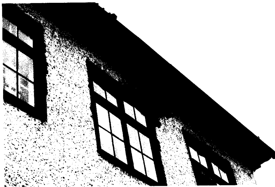
Nieszczelne rynny ubytki tynków
