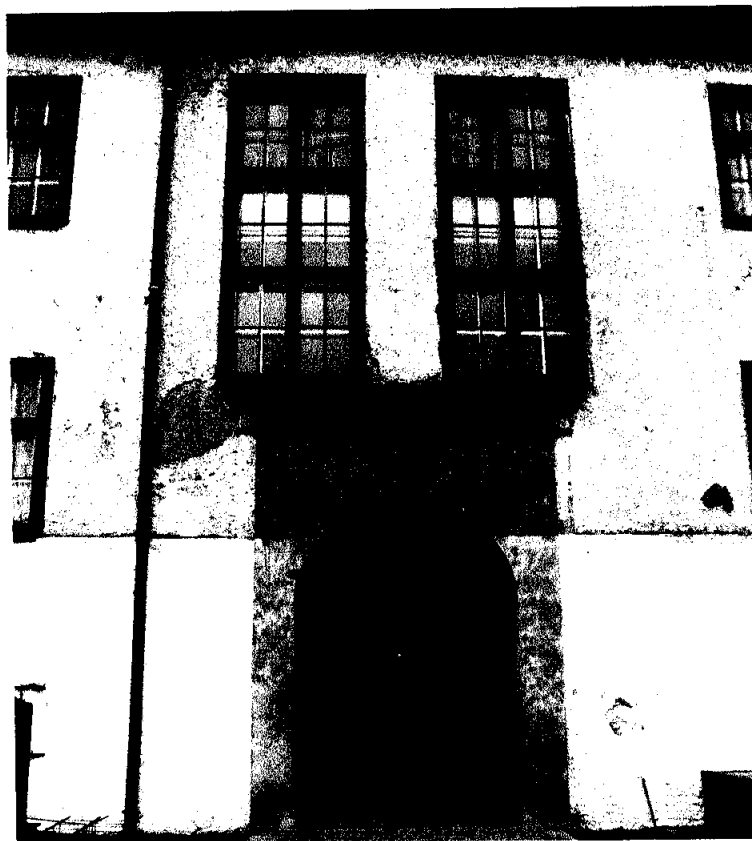
Nieszczelne rynny ubytki tynków
