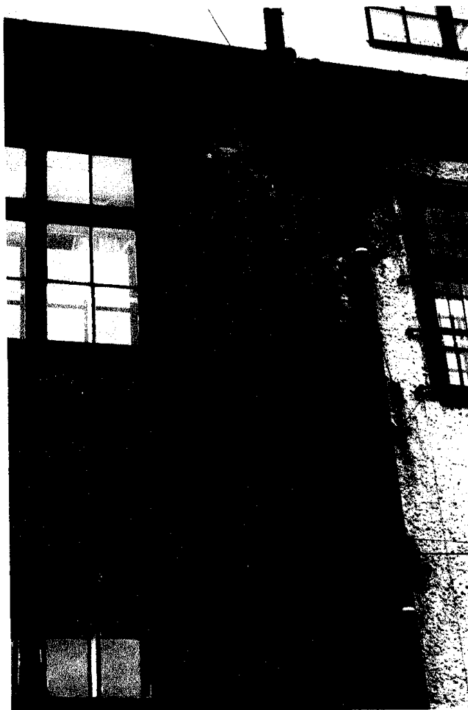
Elewacja skorodowana na skutek nieuszczelności obróbek blacharskich.
