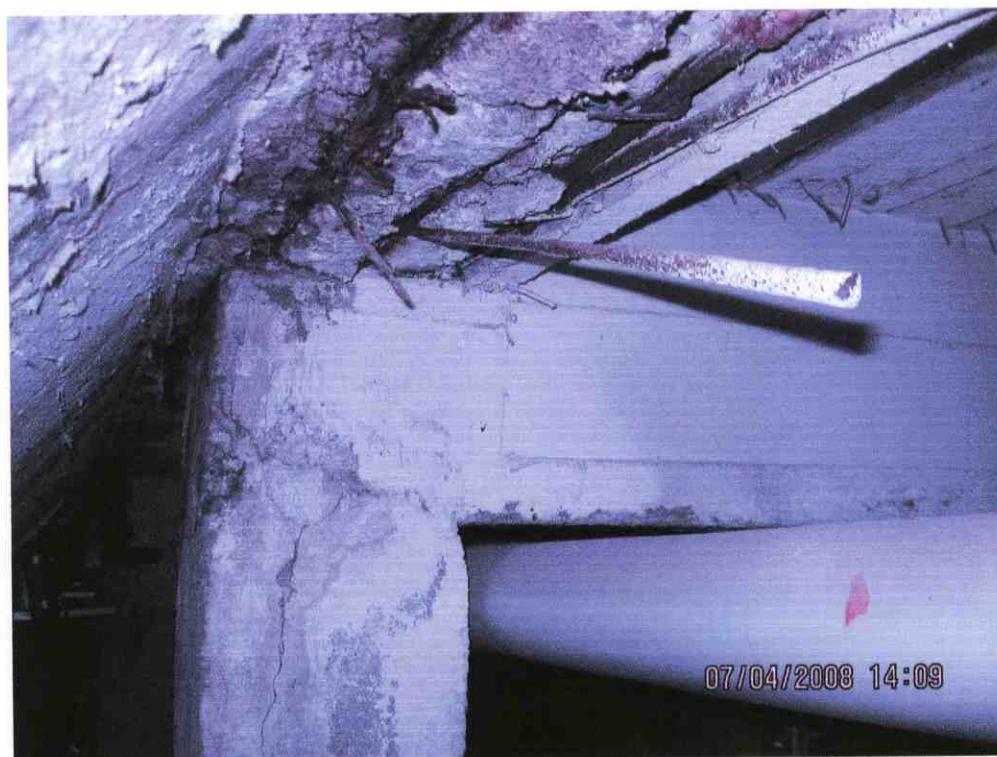
Foto Nr 14 – Zniszczona konstrukcja podpory widowni.
