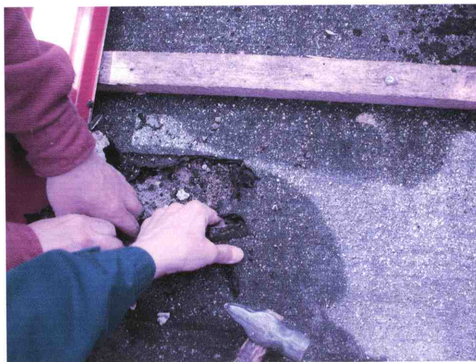
Foto nr 4- Odkrywka pokrycia dachowego nad niecką basenu.
