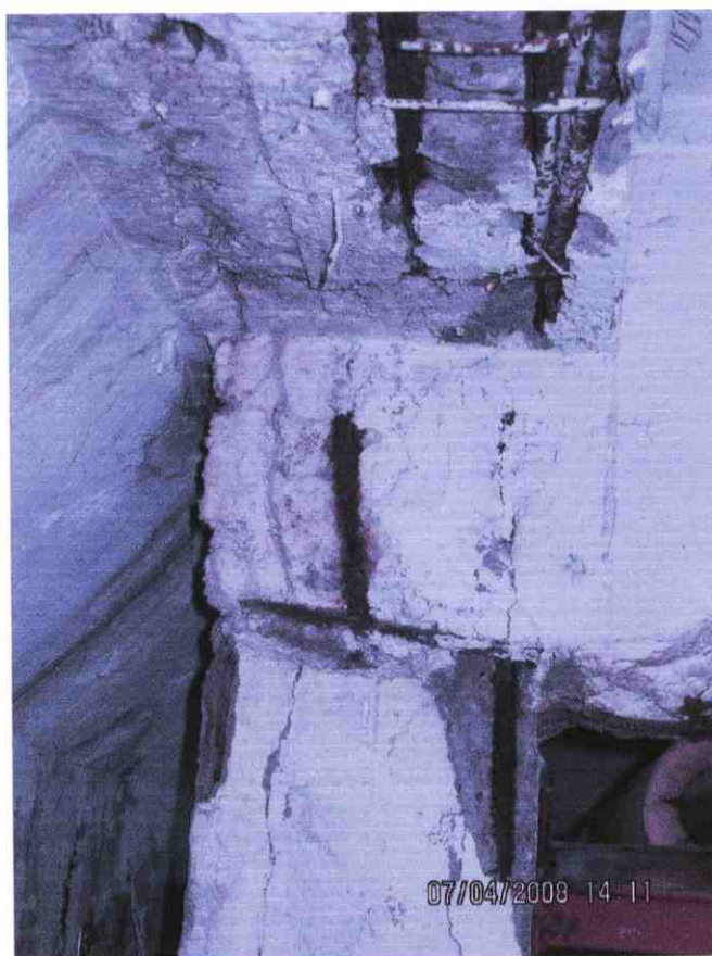
Foto Nr 16 - Zniszczona konstrukcja podpory widowni.
