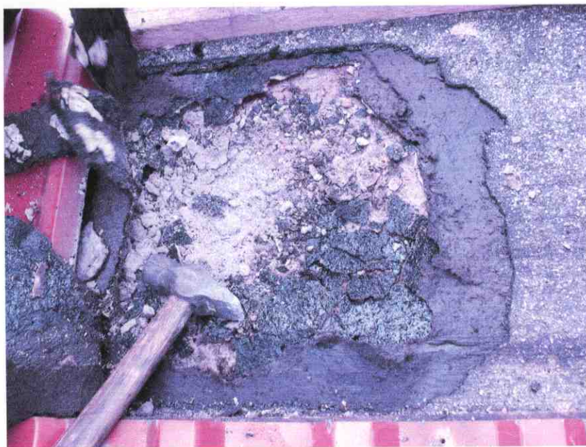
Foto Nr 5 - Odkrywka pokrycia dachowego nad niecką basenu.
