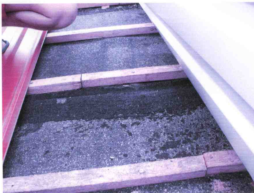
Foto Nr 3 – Odkrywka pokrycia dachowego nad niecką basenu.
