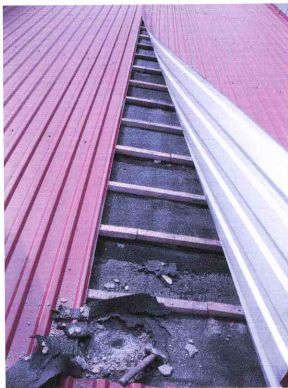
Foto nr 7 - Odkrywka pokrycia dachowego nad niecką basenu.
