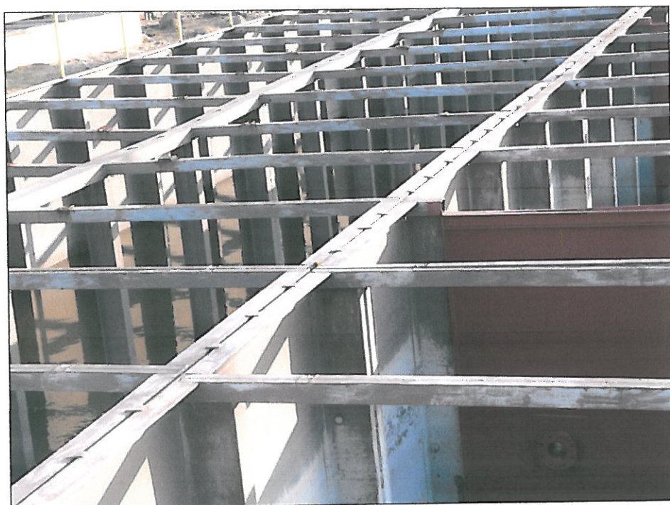
Zdjęcie Nr 2 – Widok ogólny – widoczna przepona z blachy stalowej.
