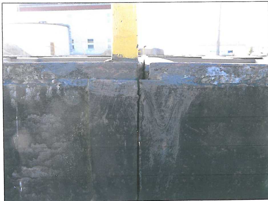
Zdjęcie Nr 3 – Miejsce połączenia poszczególnych segmentów w zbiorniku.
